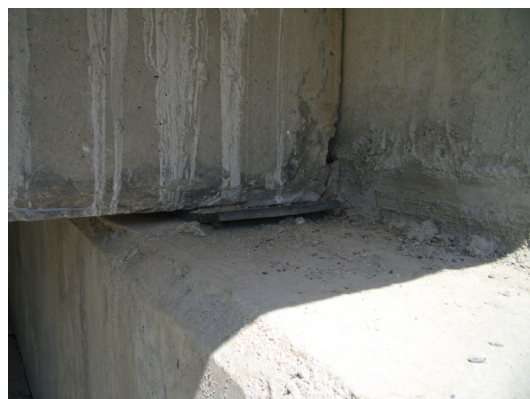
รูปที่ 4-14 แผ่นฐานรองคานแบบชนิดแผ่นยาว
