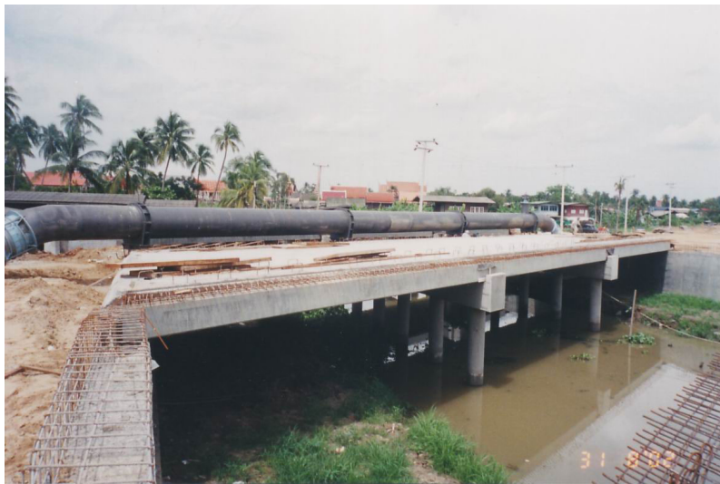
รูปที่ 4-12 เสาตอม่อดัดบริมและเสาสะพาน
